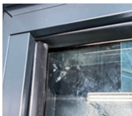
Beispielbild: Dichtungen eingebaut
